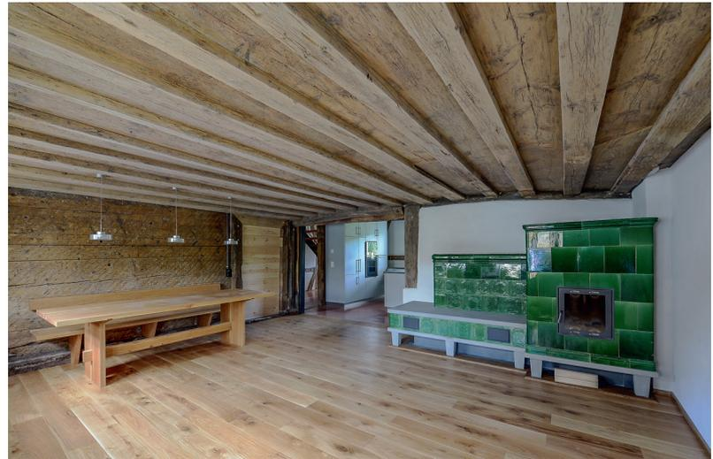
walmung verstärkt den Dachstuhl. Der Zimmermann ergänzte im ganzen Haus die teilweise lädierte Holzkonstruktion in herkömmlicher Weise.
