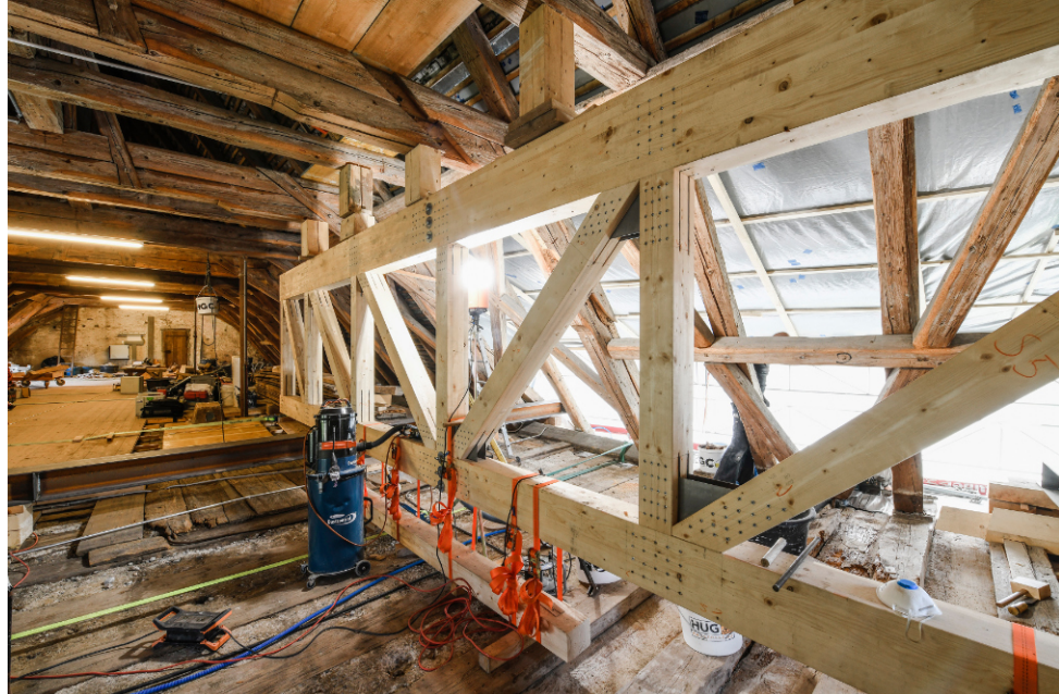
Fachwerkträger als Konstruktionshilfe für die folgenden Restaurierungen.
