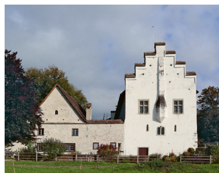
Ritterhaus Bubikon: Restauriert wird der rechte Teil.
