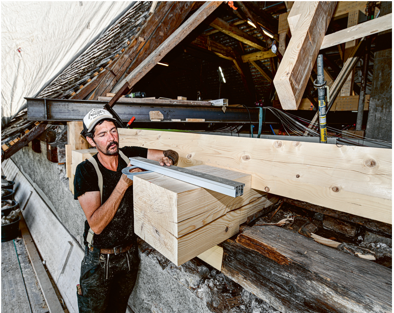
Remi Schlegel zeichnet im Dach des Ritterhauses Bubikon den Abschnitt des Dachbalkens an.
